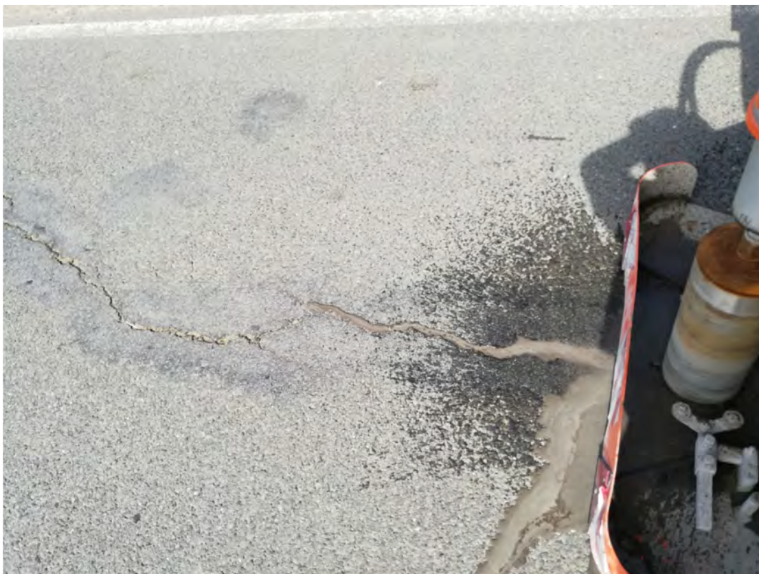
Obr. 7 Pohled na trhlinu v místě odběru vývrtu JV4
